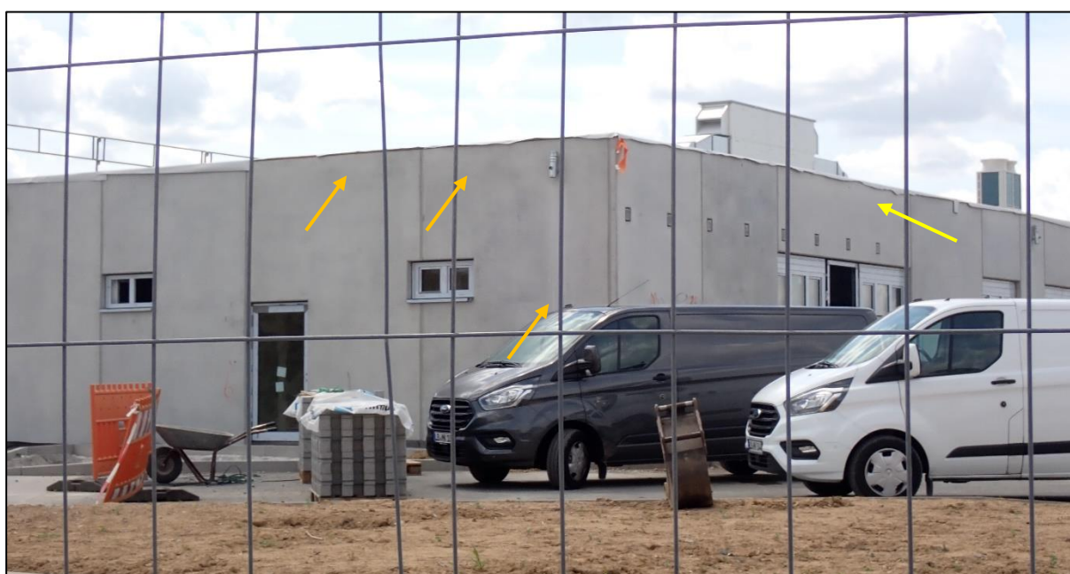
Abbildung 15: VNH Sperlingskolonie Nr. 8 und 9 (orangene Pfeile) und VNH Nischenbrüter Nr. 6 (gelber Pfeil) am neuen Pfortnerhäuschen (noch nicht im Luftbild zu sehen).
